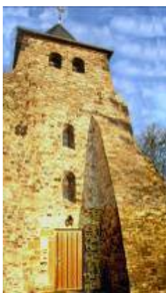
Turm mit Eingang
