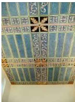
Bemalte Holzdecke im Hauptschiff
