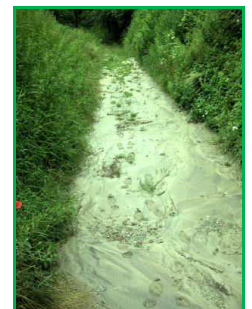
Erosion nach Gewitter 11
