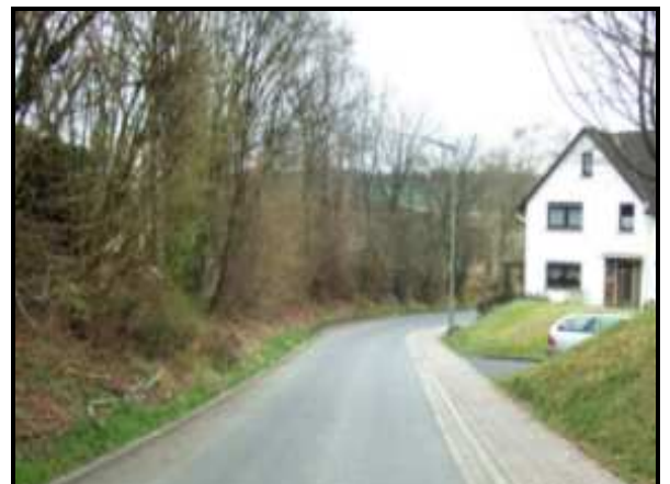
Die heutige Schulstraße war einst ein Hohlweg aus Richtung Amteroth. Unterhalb der Kirchstraße ist die östliche Böschung des Hohlwegs noch gut erhalten geblieben. Die gegenüberliegende Böschung veränderte sich durch verschiedene Baumaßnahmen. Abb.4
